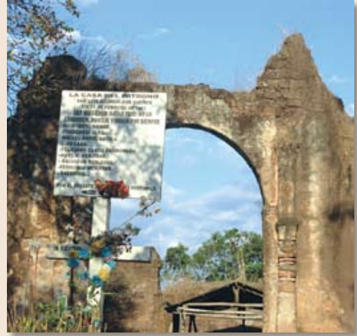
Ruinas de la iglesia de Aguacayo. La ciudad de Aguacayo posee la tradición de fabricación de dulces artesanales.
